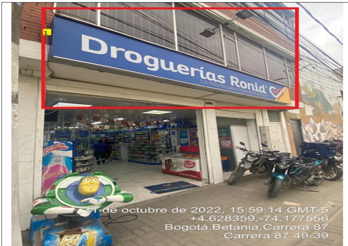
En la cual se evidencia un (1) elemento tipo aviso en fachada ubicado en antepecho de segundo piso perteneciente al establecimiento comercial DROGUERÍAS RONID BETANIA , propiedad de la sociedad INVERSIONES RONID SAS , el cual al momento de la visita se encontraba instalado sin el registro ante la SDA.
